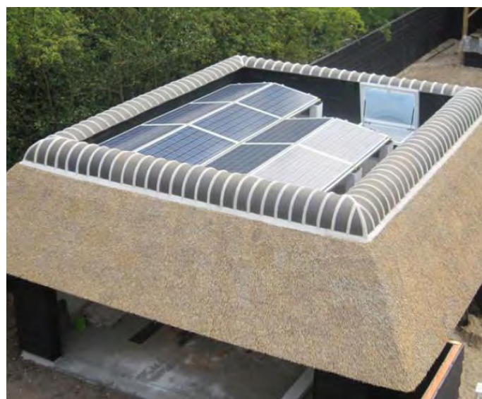
PV-panels uit het zicht op het platte deel van de rieten kap
