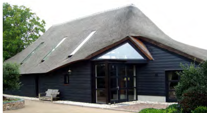
Schuine rieten kap in combinatie met houten geveldelen
